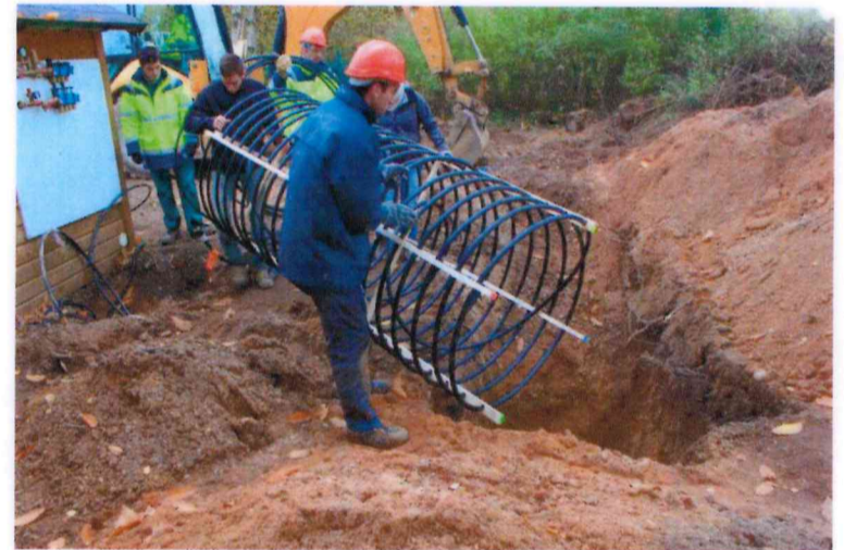
Corbeilles géothermiques – source BRGM
