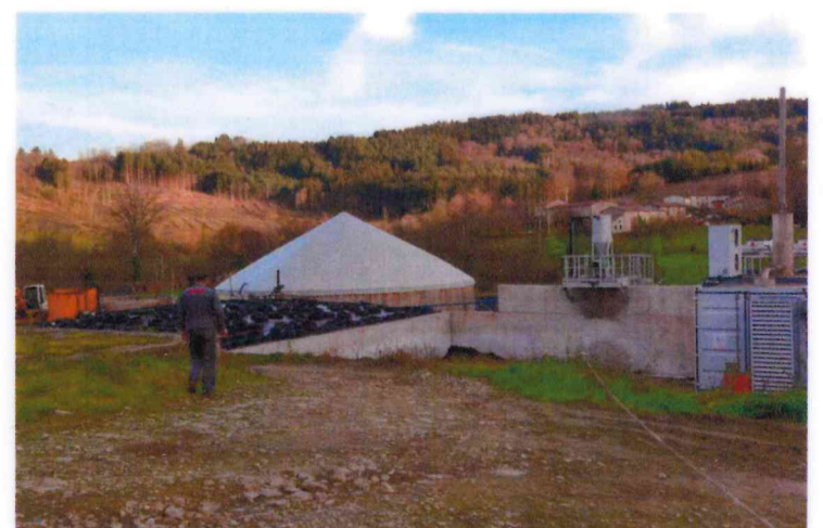
Unité de méthanisation située à Cunlhat
