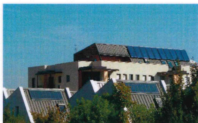
Chauffe-eau solaire sur des maisons (premier plan) et un immeuble de logement.
